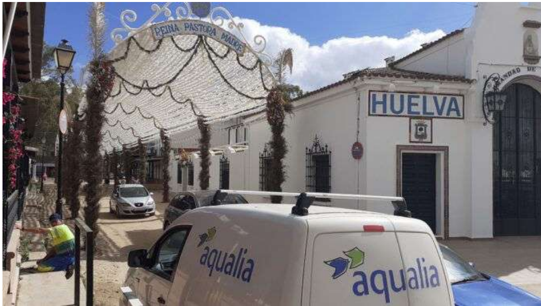
Aqualia realiza labores de infraestructura hidráulica en El Rocío
